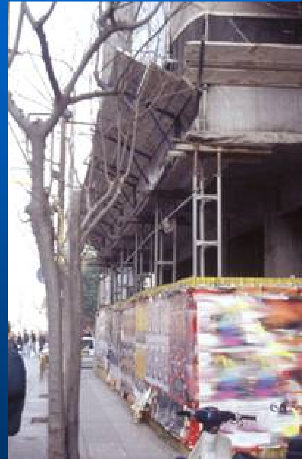
Κτήριο υπό επισκευή
